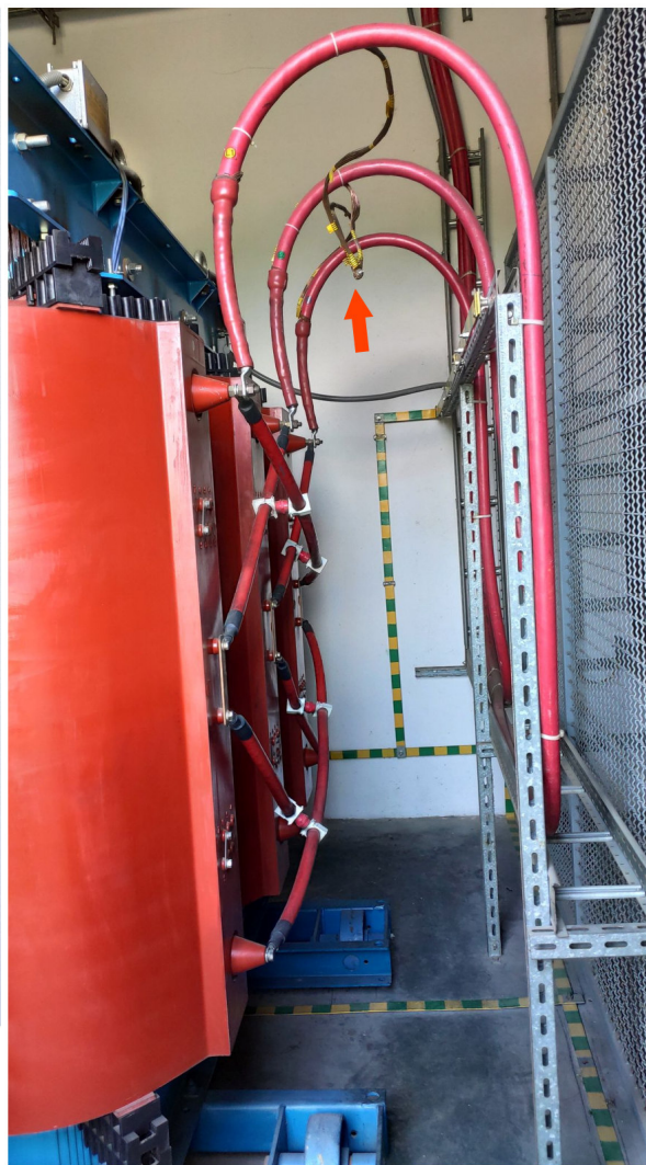
Rys. 7.65: Mikser - brak uziemienia żył powrotnych kabli SN
