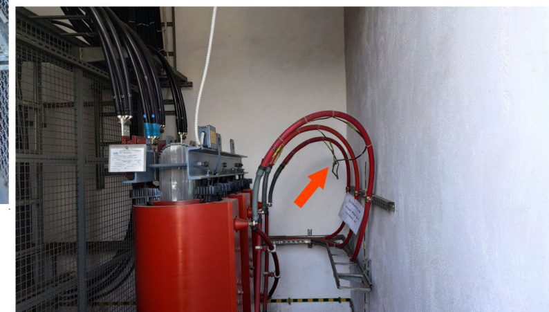
Rys. 7.67: Mikser - brak uziemienia żył powrotnych kabli SN
