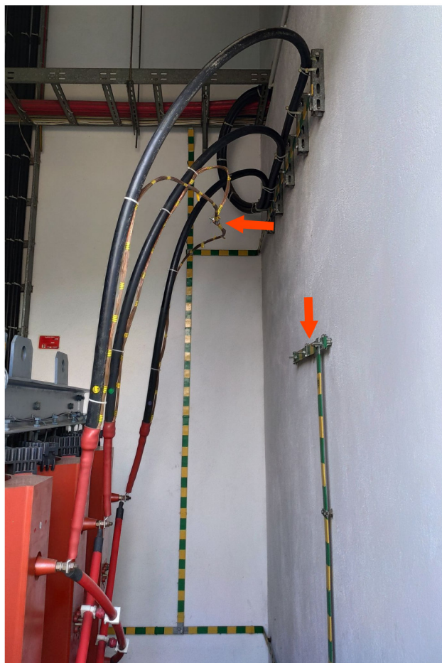
Rys. 7.64: Mikser - brak uziemienia żył powrotnych kabli SN
