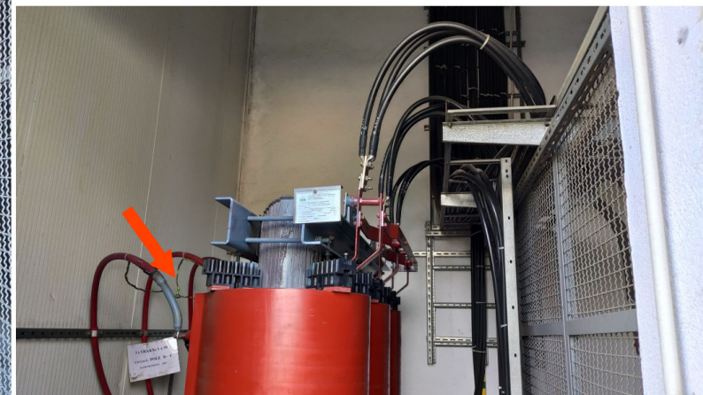
Rys. 7.66: Mikser - brak uziemienia żył powrotnych kabli SN
