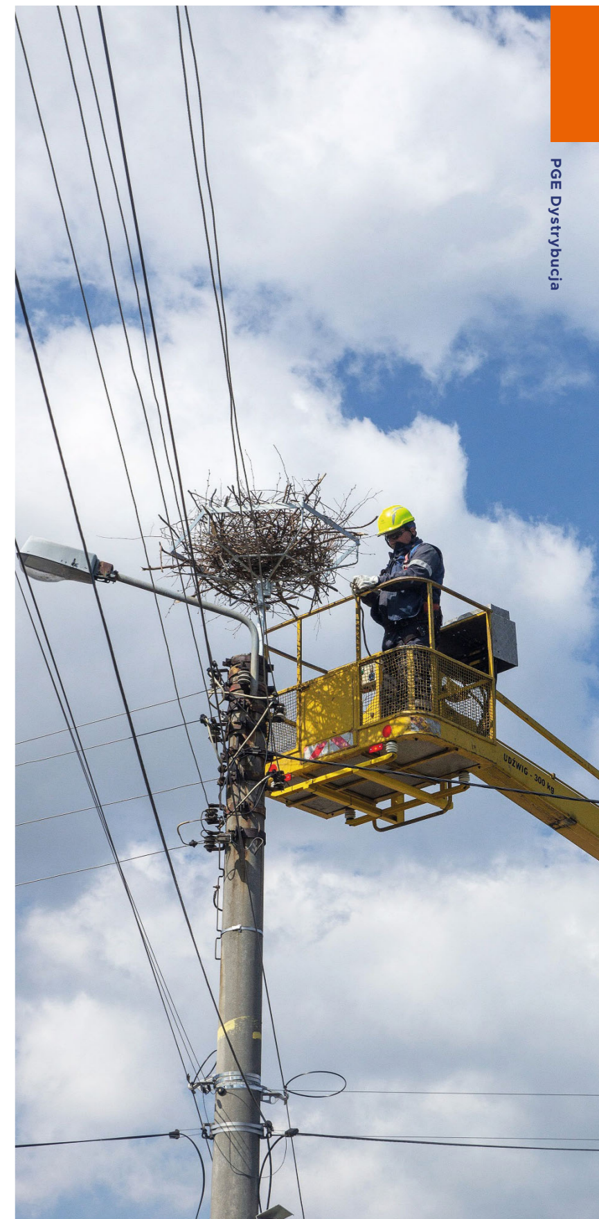
PGE Dystrybucja, Platforma gniazdowa
