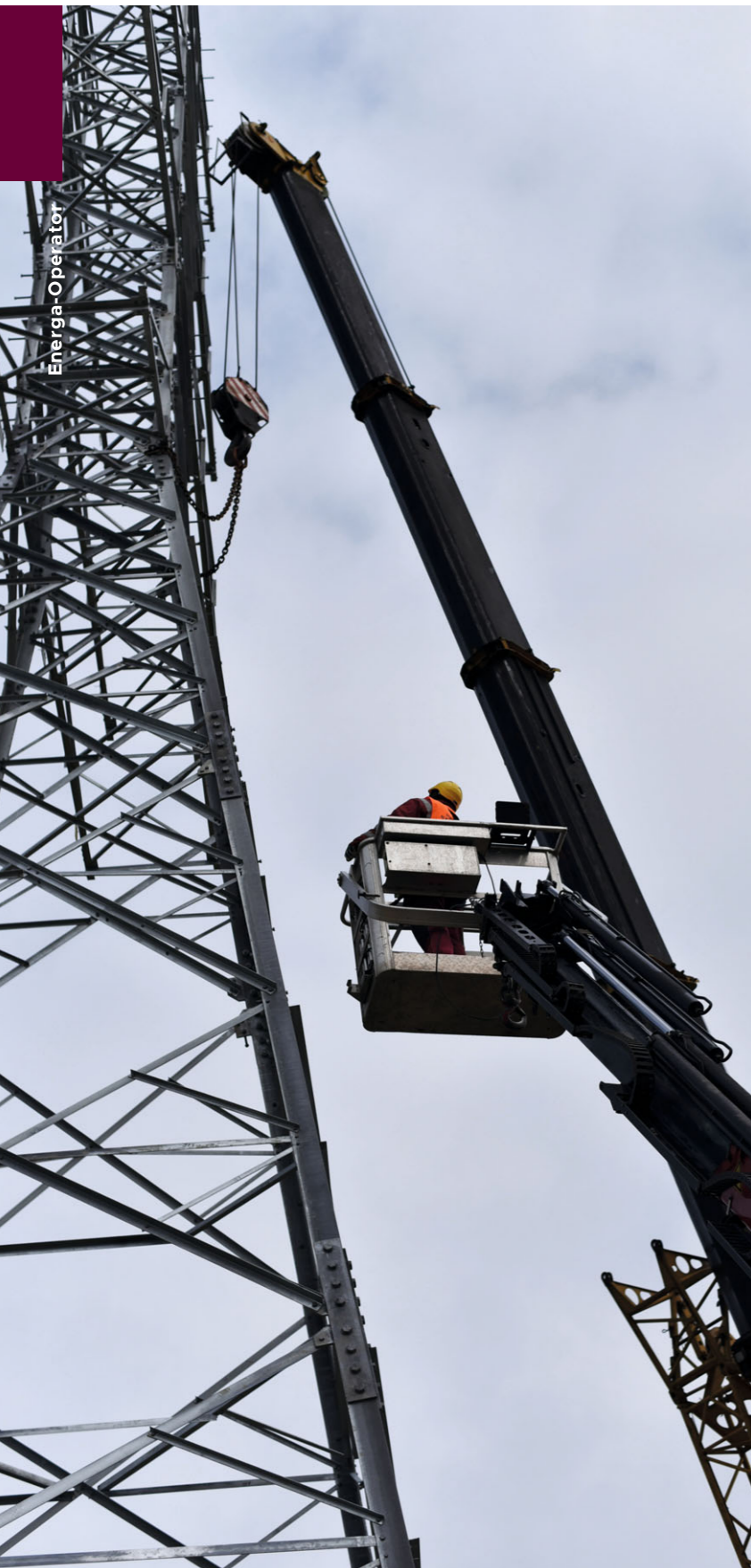
Energa-Operator, Budowa linii WN
